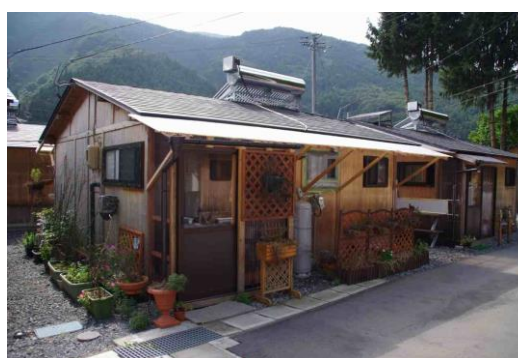
軒先を延ばした仮設住宅（火石）
